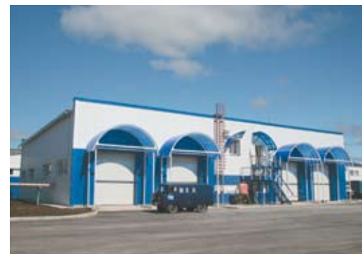
Механизированная мойка УАТК УТТиСТ с очистными сооружениями, оборотным водоснабжением и контрольно-регулируемым пунктом
