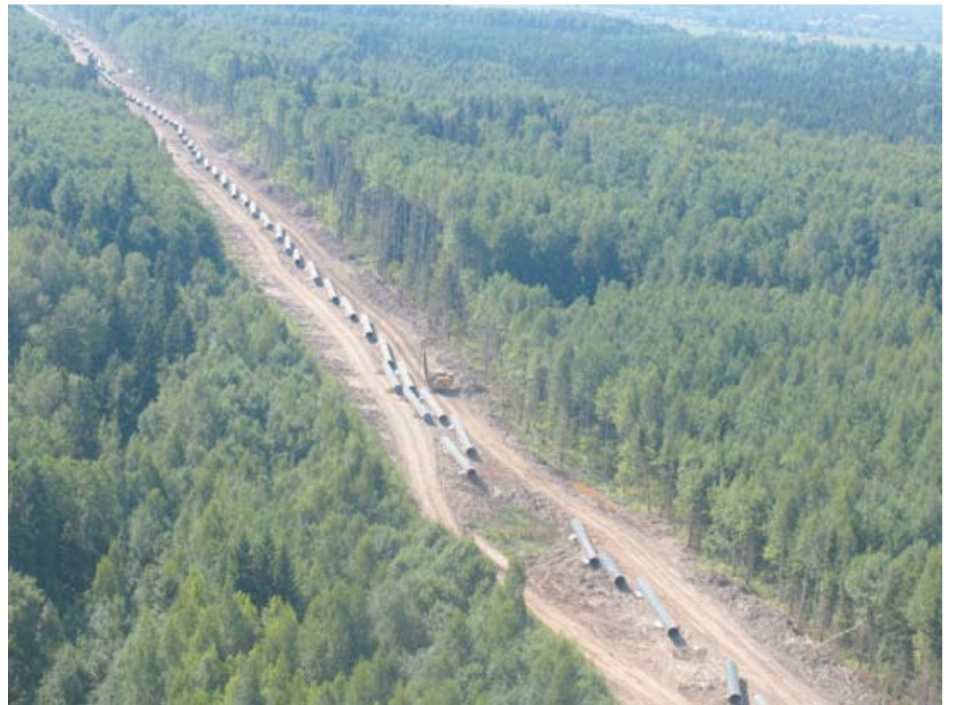
Строительство МГ «Починки - Грязовец», участок км 80-174
