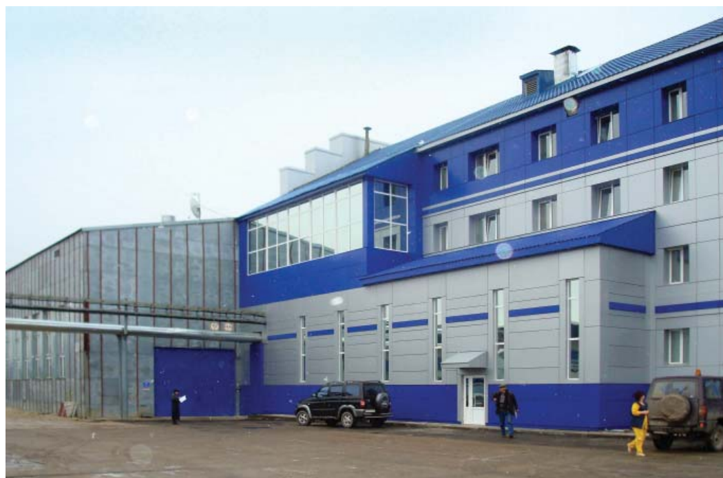
Здание административно-бытовое АВП УАВРа
