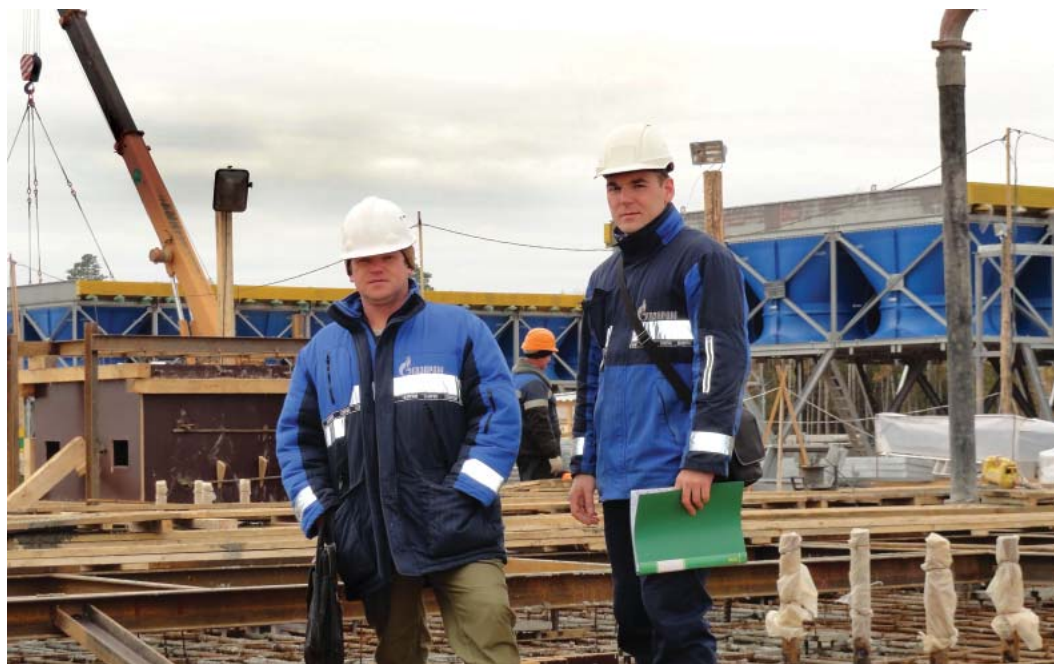
С. Лобазов и С. Чумичкин на бетонировании фундамента под ГПА
