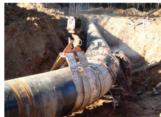
Сварка и укладка выходного шлейфа КЦ-6
