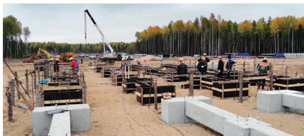
Монтаж фундаментов под АВО-газа КЦ-6
