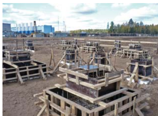
Монтаж опалубки фундаментов ПЭБ КЦ-5
