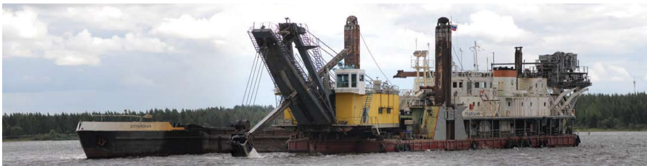
Строительство подводного перехода МГ «Починки-Грязовец» через реку Волгу
