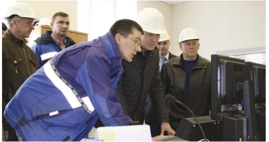
Пуль управления КС «Бабаевская», цех №3
