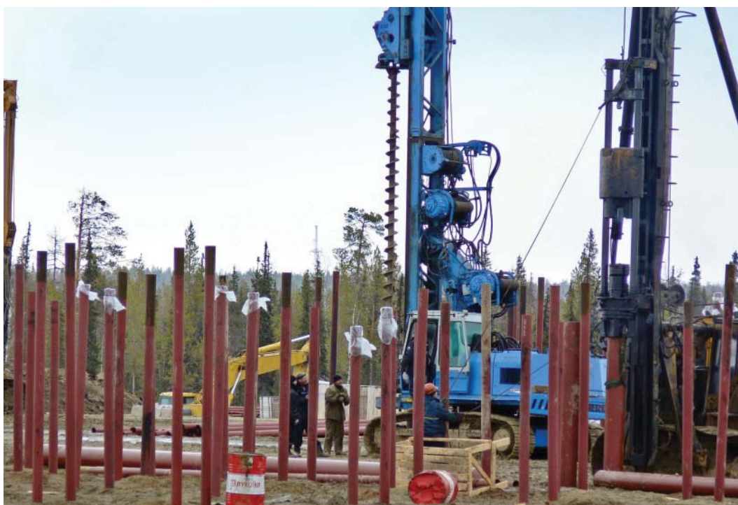
Ведутся работы по забивке свай на КС-8 Чикшино
