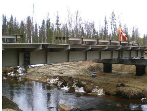
Монтаж мостового перехода автодороги КС-8. Чикшино
