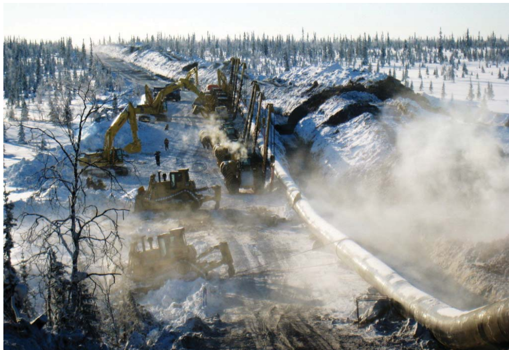
Идет работа по укладке плети на Сивой Маске
