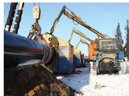
Идут работы по сварке трубопровода на линейной части
