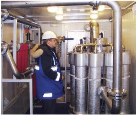
Садовников Сергей Сергеевич внутри азотной установки контролирует показания приборов: температуру точки росы и процентное содержание кислорода в азоте на выходе из установки.
