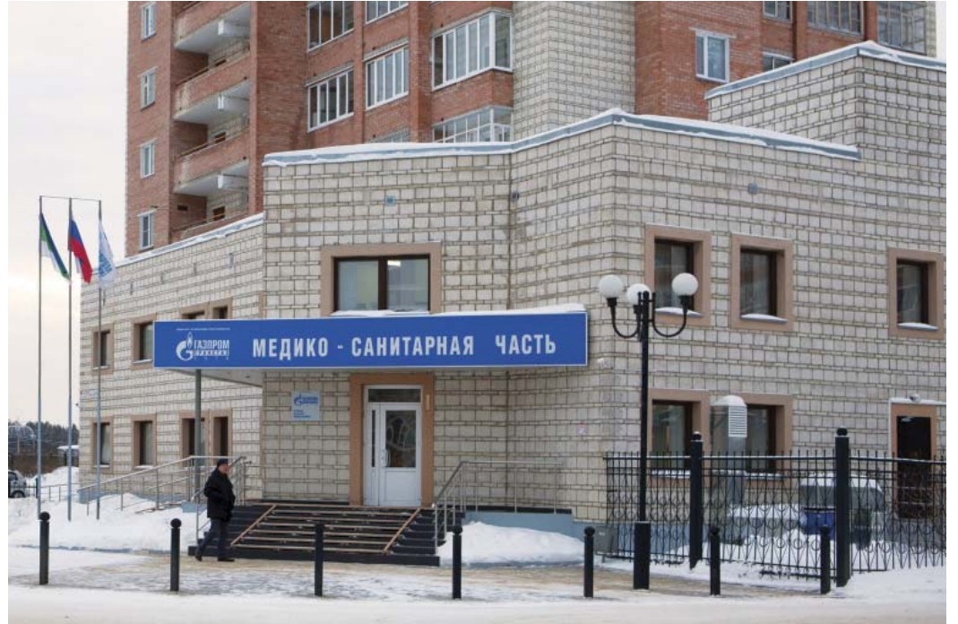
Здание поликлиники МСЧ
