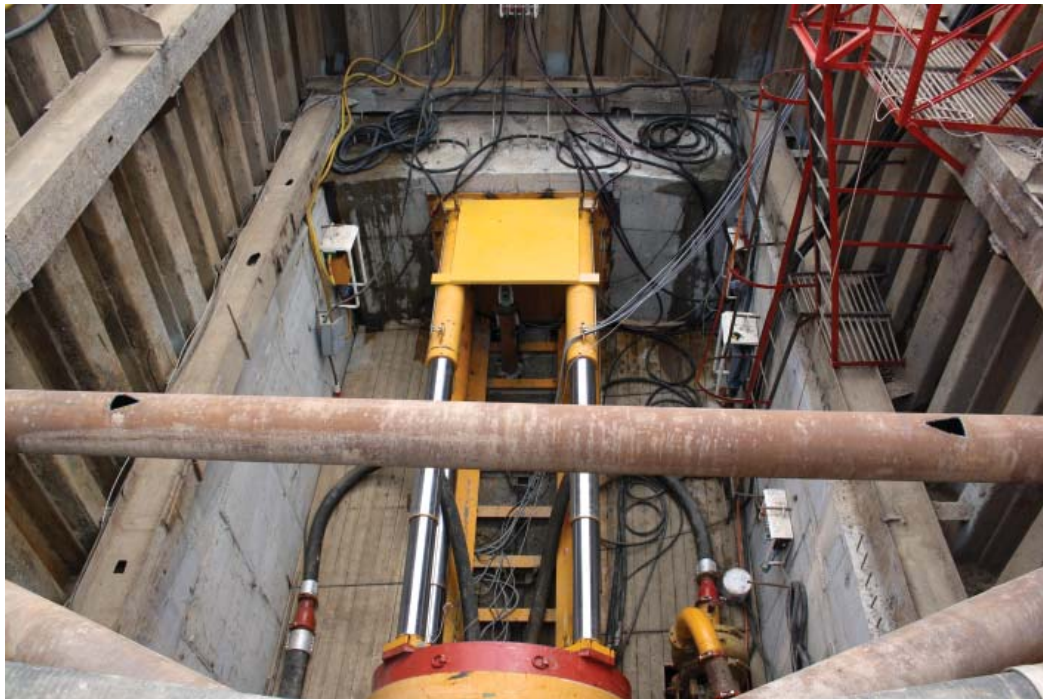
Горнопроходческий комплекс для бурения и прокладки туннеля под газопровод
