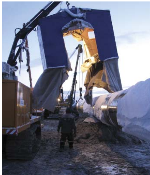
Работа сварочного комплекса CRC- Evans
