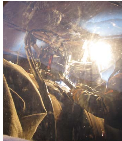
Работа сварочного комплекса CRC- Evans
