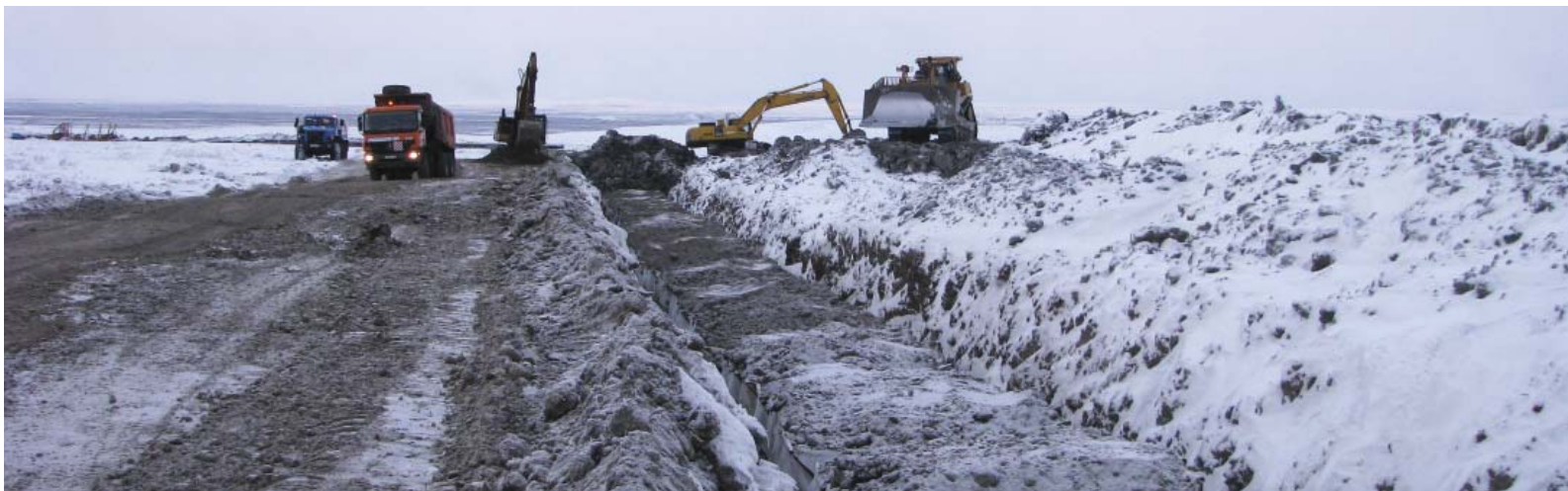
Обратная засыпка построенного участка магистрального газопровода «Бованенково - Ухта (вторая нитка)»
