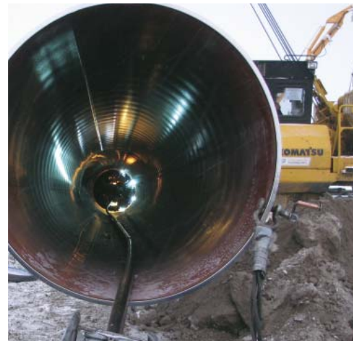
Внутренняя подварка корня шва
