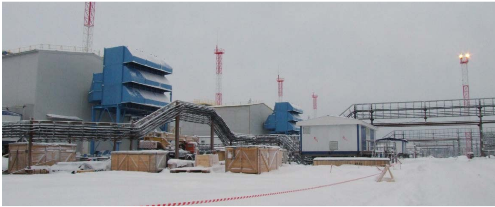
Объект строительства КС-Интинская входит в состав Системы магистральных газопроводов Бованенково - Ухта в границах обслуживания Печорского ЛПУМГ и расположен недалеко от Северного полярного круга, примерно в 25 км от города Инты.
