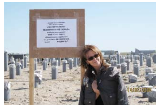
На строительной площадке
