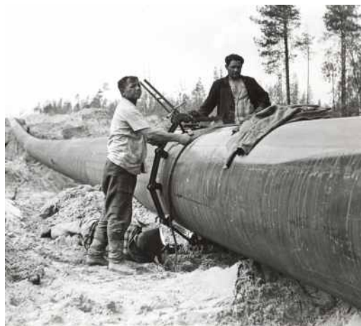
Строительство газопровода «Вуктыл – Ухта», 1970 г.
