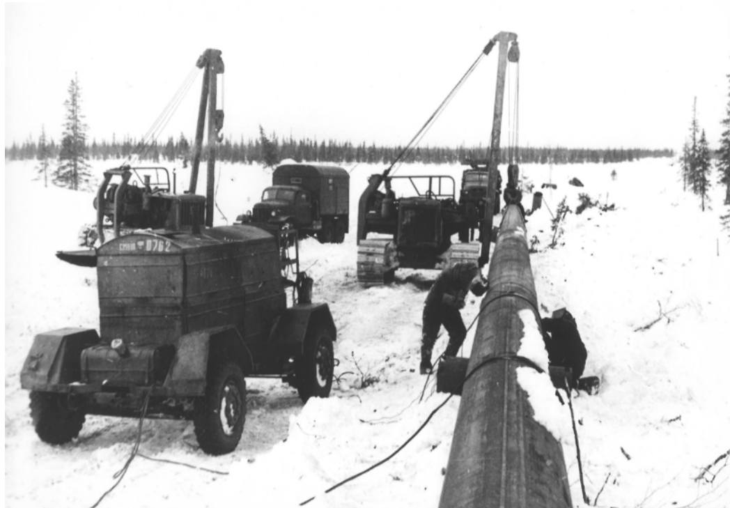
Строительство газопровода «Северное Сияние», 1971–1972 гг.
